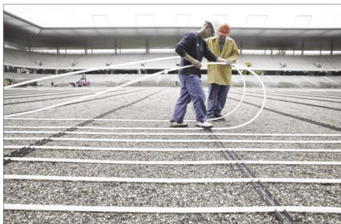
фиг. 12-3 Полагане на отоплителните тръби
