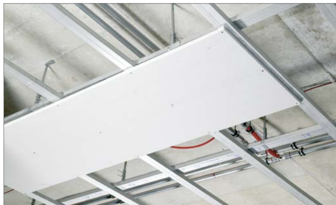
фиг. 4-37 Монтиран стенен елемент към таван
