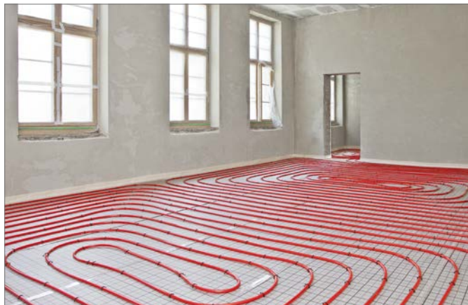
фиг. 3-22 Такер система
