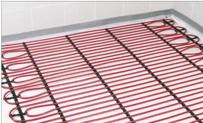
фиг. 3-114 Подова фиксираща шина при мокро строителство
