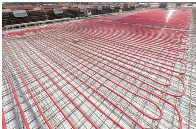
фиг. 8-3 REHAU BKT модули
